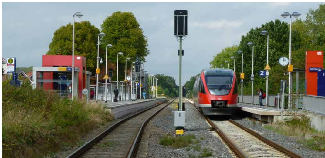
RB 64 auf der Strecke Münster – Enschede im zweigleisigen Begegnungsbahnhof Aitenberge
