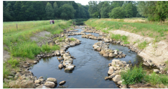
Sohlgleite mit Beckenpass, durchgängig für Wasserorganismen
