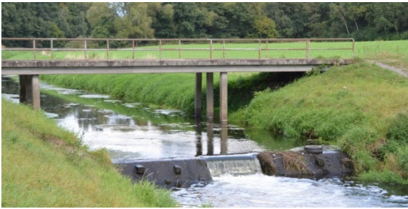
Unüberwindbarer Sohlabsturz in der Hessel
