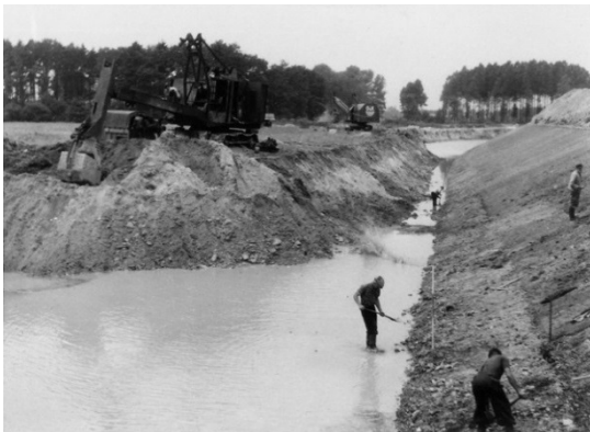
Emsausbau bei Einen 1953
