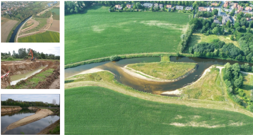
Initialgerinne verlängern die Fließstrecke der Ems
