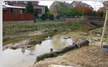
**Eigendynamische Entwicklung durch Rückbau von Sohl- und Uferverbau**
