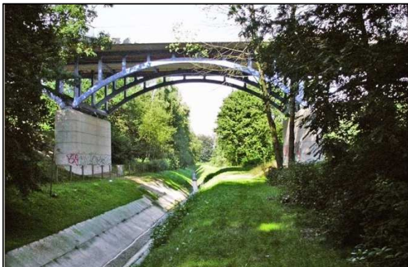
Foto Borbecker Mühlenbach: Schmutzwasserlauf
