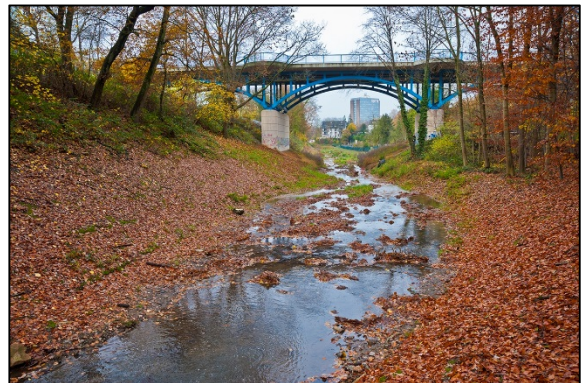
Foto Borbecker Mühlenbach: nach Umgestaltung
