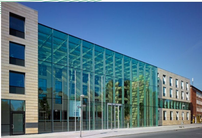
„Transparenz und Vielseitigkeit“: Das sanierte Gebäude im Jahr 2006
