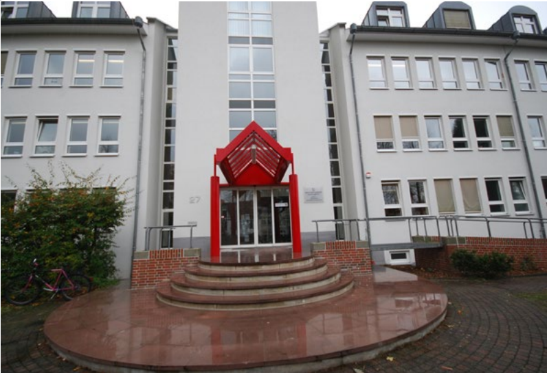
Emscher-Lippe-Haus – Gartenstraße 27 in Herten
