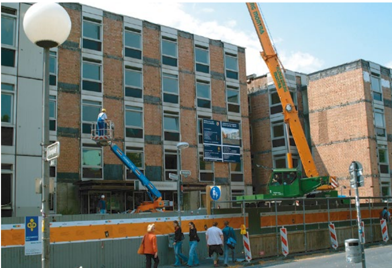
Sanierung des Regierungsgebäudes ab Sommer 2005
