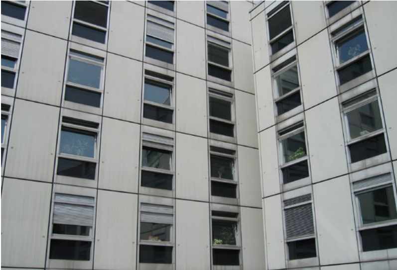
Büros im Innenhof des Gebäudes kurz vor der Sanierung 2005
