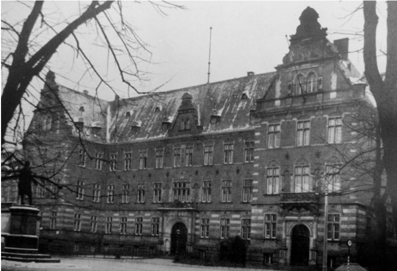
Der Neubau der Regierung zu Münster, 1890
